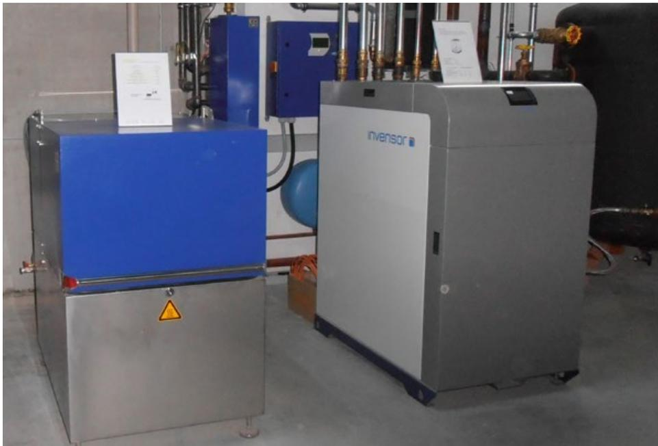
**Abbildung 2:** BHKW mit Adsorptionskältemaschine; Kältemaschine: InvenSor LTC 10; Kälteverteilung: Wärmetauscher; Kälteleistung: 10 kW; Antriebswärme: EC Power BHKW
