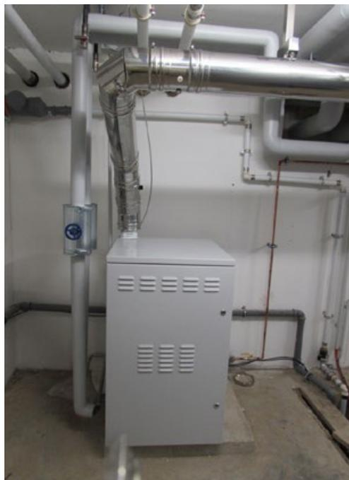
**Abbildung 2:** Brennstoffzelle BlueGEN.
