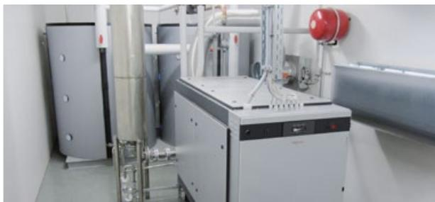
**Abbildung 5:** Wo parallel Strom und Wärme kontinuierlich über einen längeren Zeitraum benötigt werden, sind Blockheizkraftwerke wie das abgebildete Vitobloc 200 eine besonders wirtschaftliche Lösung.
