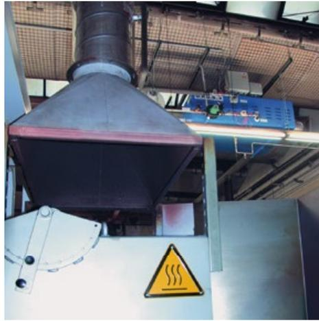
**Abbildung 3:** Das neue Heizungssystem bei Reiners + Fürst integriert die vorhandenen Energieströme – auch die Abwärme des Härteofens wird genutzt.
