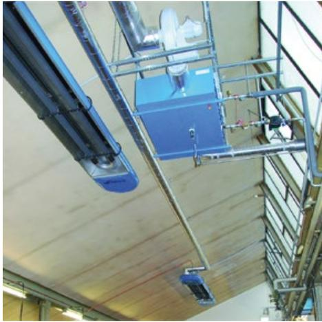
**Abbildung 2:** Infrarotgeräte Typ OPTIMA plus mit Restwärmenutzung – das neue Heizungssystem H.Y.B.R.I.D. von KÜBLER ist hocheffizient.
