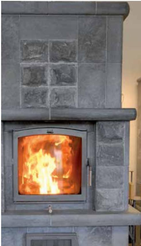
Moderne Holzöfen verfügen über einen schamottierten, optimal dimensionierten Brennraum und erzielen hohe Temperaturen und ausreichend lange Ausbrandzeiten. Primär- und Sekundärluftzufuhr sollten getrennt regelbar sein.
