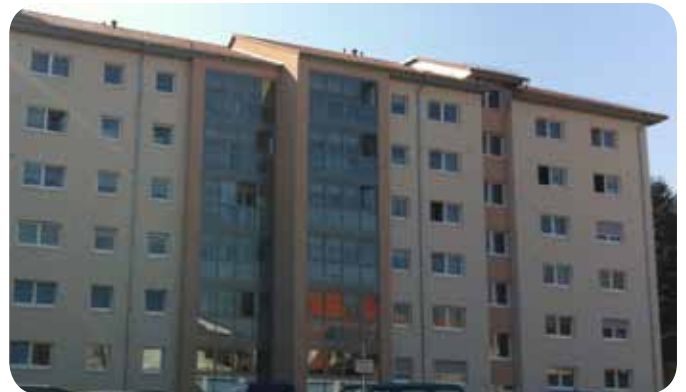
Fassade nach der Sanierung.
