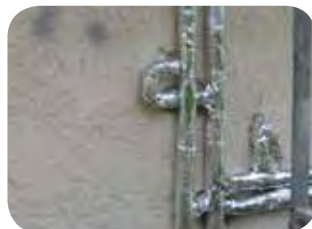
...Heizleitungen, auf der Fassade unter der Dämmung montiert
