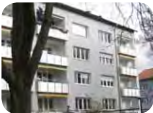
Die Rückseite nach der Sanierung
