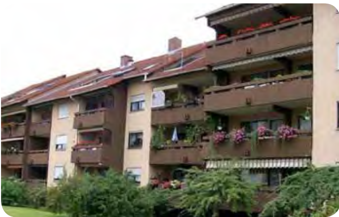
Das Gebäude vor der Sanierung...
