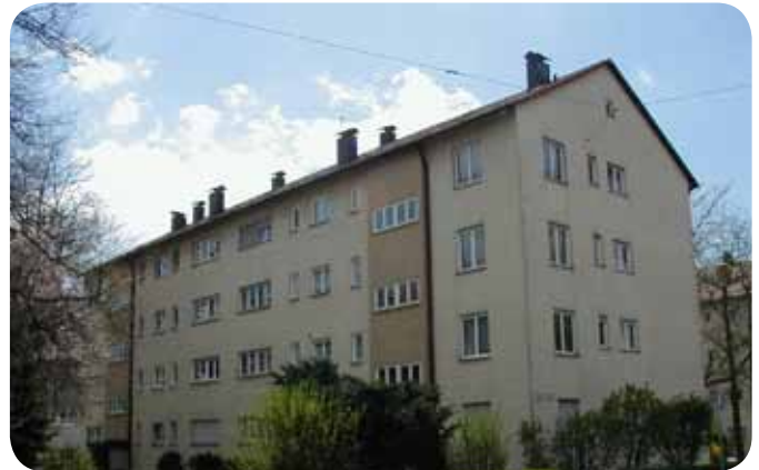
Das Gebäude vor der Sanierung...
