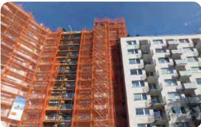
Die Fassade wurde mit einem WDVS-System runderneuert.
