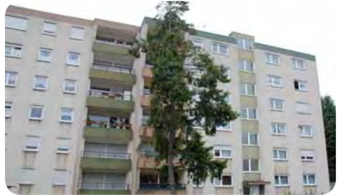
Ansicht der Fassade im Bestand.
