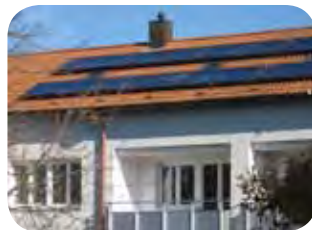
Das runderneuerte Dach
