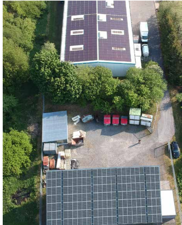
PV-Strom vom Firmendach (Foto: Waldorf GmbH)
