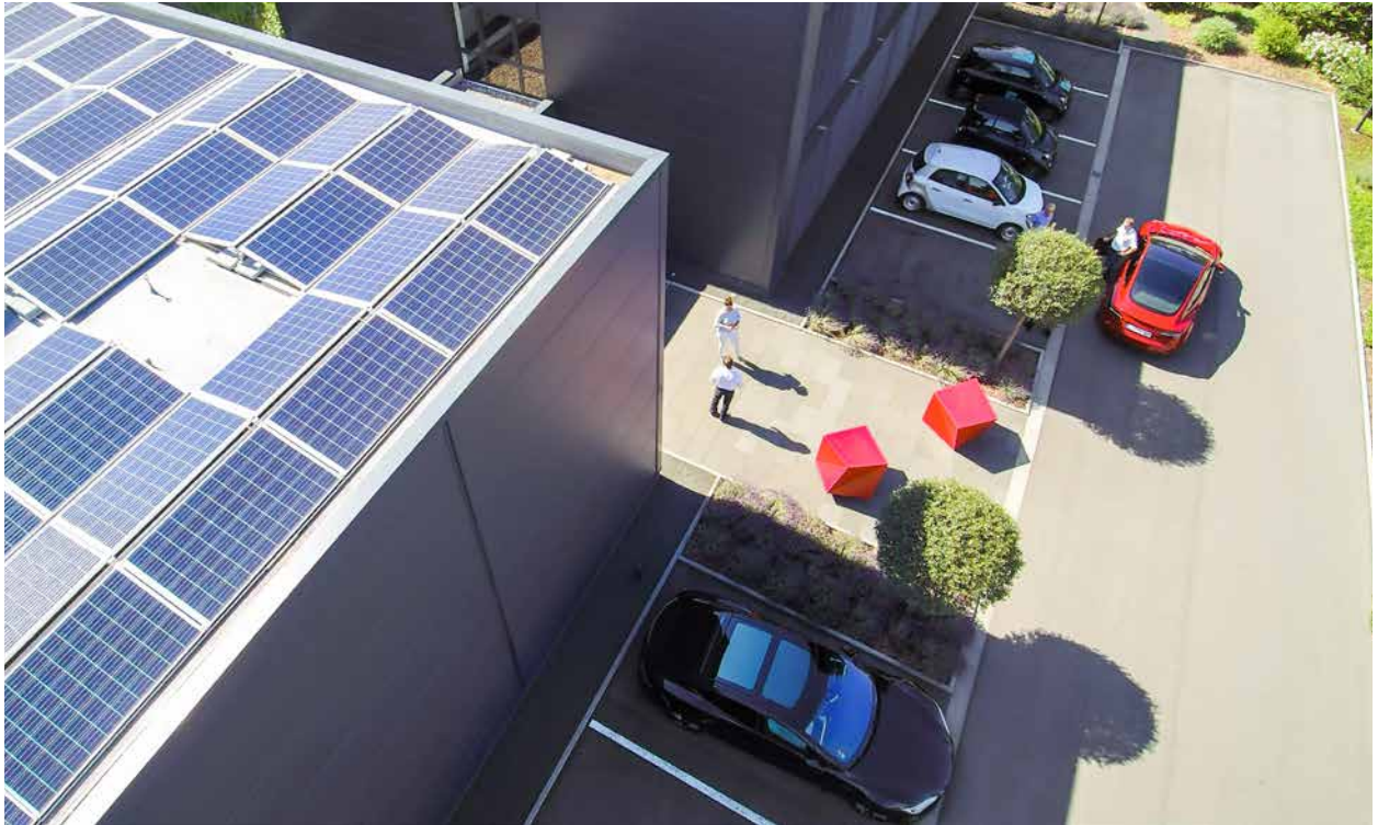
Das Aufladen von E-Autos auf dem Betriebsgelände mit eigens erzeugtem PV-Strom ist kostengünstig und umweltfreundlich
