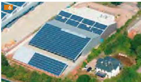
PV-Anlage Fa. Ellenberger, Kaiserslautern (Bild: damm-solar)
